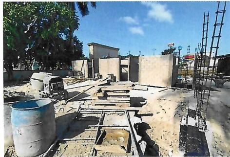
F1: Fachada principal
